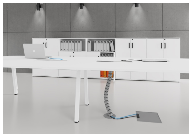
Svedení kabelů samostaným svodem.
